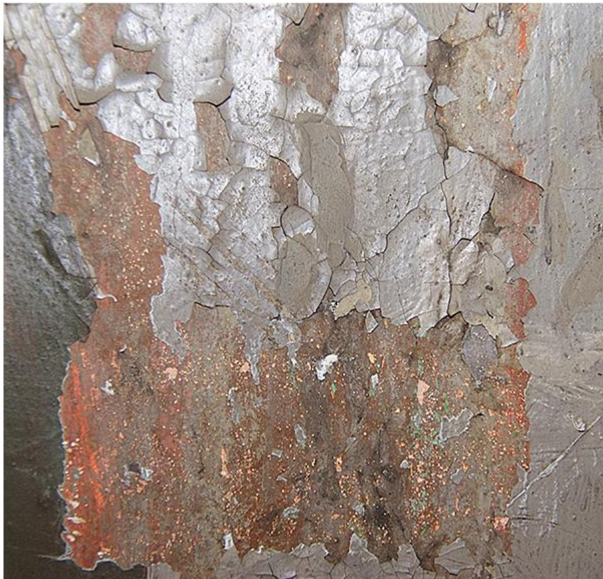
Pronaos - nord, detaliu în care se observă exfolierile repictării în ulei Image 2 of 7
